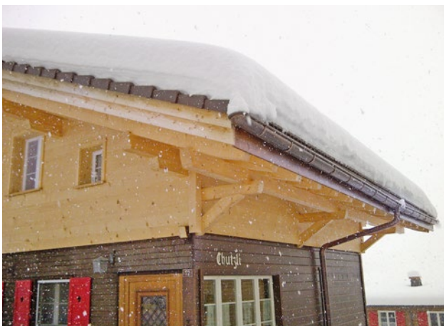
Bild 16: Vordach gedämmt, kaum Rückschwellwasser
