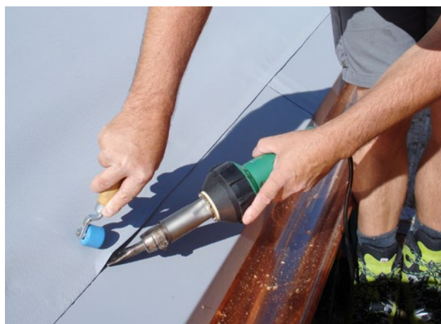
Bild 13: Unterdachbahn auf kaschiertem Einlaufblech. Stösse beim Einlaufblech sind zu verschweissen.
