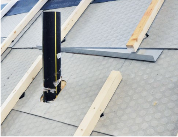
Bild 5: Abweisblech seitlich über die Konterlatten geführt
